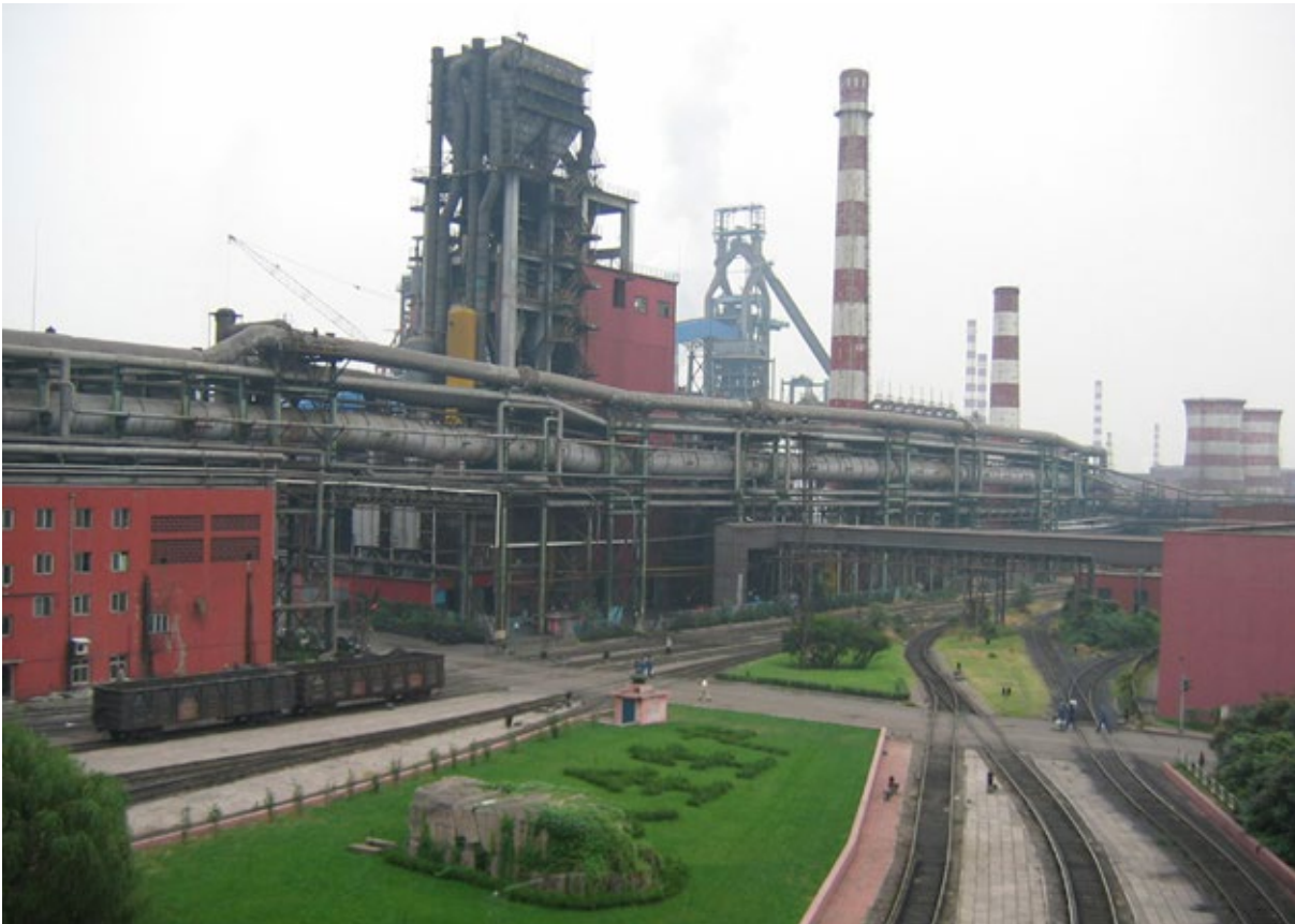
Warmwalzwerk im Stahlwerk Beijing 2005
